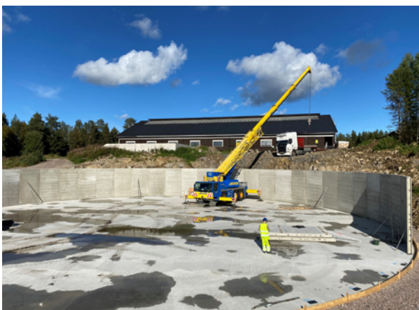
Montaget av behållarväggar går snabbt och utförs i normalfallet med lastbil med kran placerad på bottenplattan.
