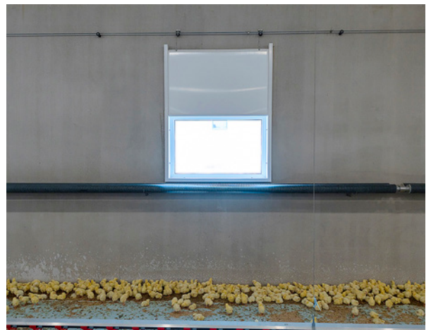
Mörkläggningsluckor i PVC monteras enkelt i de ingjutna fönstrens plastsmyg.
