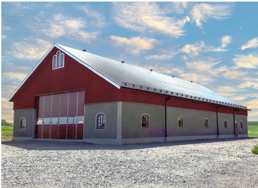
Verkstad med tre meter hög betongvägg och isolerad träregelvägg ovanför.
