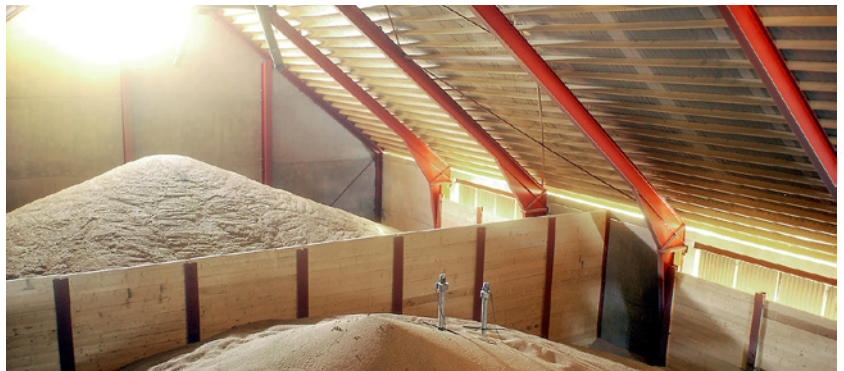
Spannmålslager med brant taklutning och plantransportör i nock, vilket ger möjlighet till lagring på höjden.
