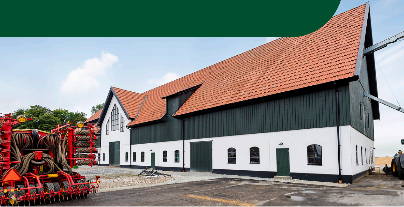
Spannmålstork, halmlager och verkstad.
