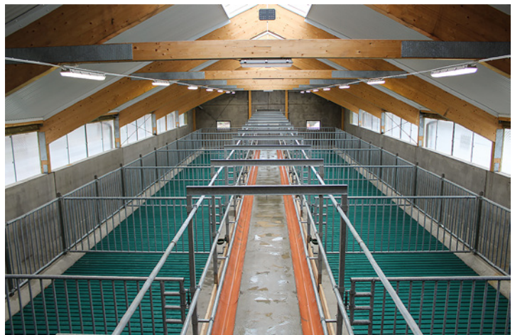
Spaltboxstall med Comfort Slat Mat. Limträstomme på betongväggar.
