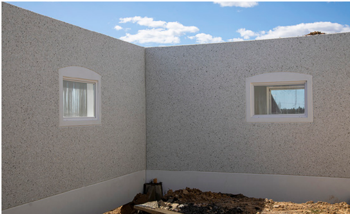
PVC-fönster gjuts in på fabriken vid tillverkning av väggelement.
