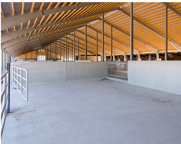
Stor djupströbox med hög, massiv betongvägg. Stålstomme med invändig pelare.
