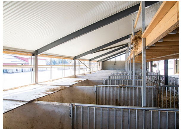
Kalvstall med avskiljande betongväggar och ströloft.
