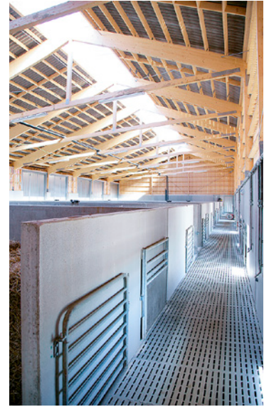
Oisolerad byggnad med limträstomme och yttertaksbeklädnad med cementfibertak. Drivgång längs yttervägg.
