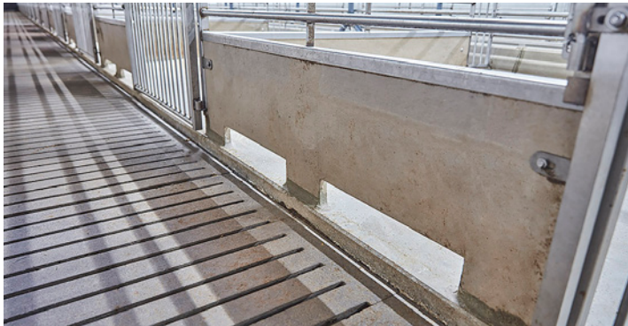
Inredningsskiva i stålfiberarmerad betong anpassad efter kundens önskemål.
