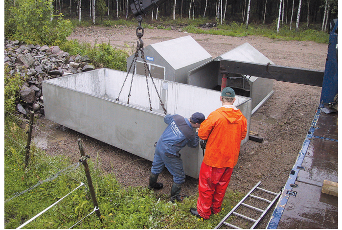
Betongdelen ställs på plats på en plan och väl avgrusad yta.
