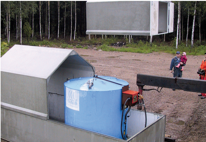
Takhalvorna monteras och infästas i bottendelen. Tack vare låg vikt kan varje takhalva även hanteras med vanlig traktorlastare. Fogning sker med medlevererad fogmassa.
