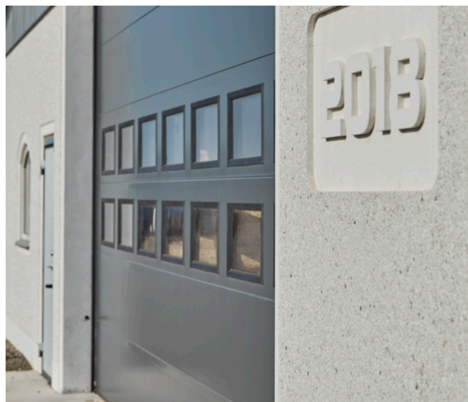
Vit friläggning i vit betong.
