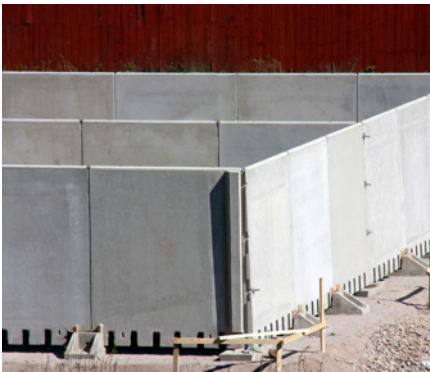
Plansilo med höjd på 3 meter är dimensionerad för 20 tons packningsmaskin, medan höjd på 4 meter är dimensionerad för 25 ton.
