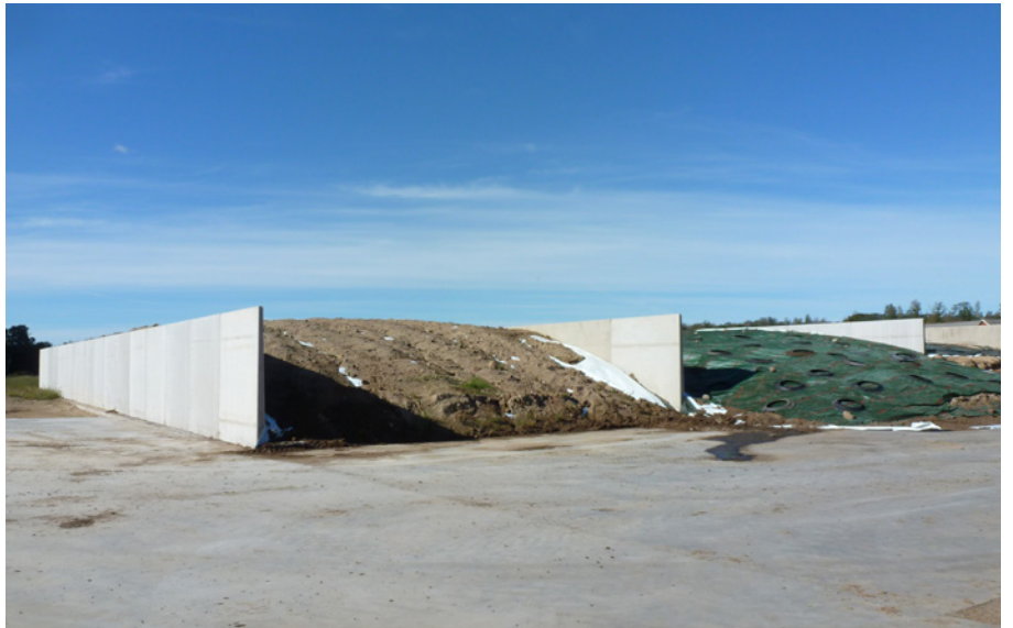
Plansilo med höjd på 3 meter är dimensionerad för 20 tons packningsmaskin, medan höjd på 4 meter är dimensionerad för 25 ton.
